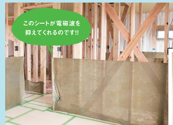
掛川市の新築現場。「スパンボンド」を取り付けた時の様子。
