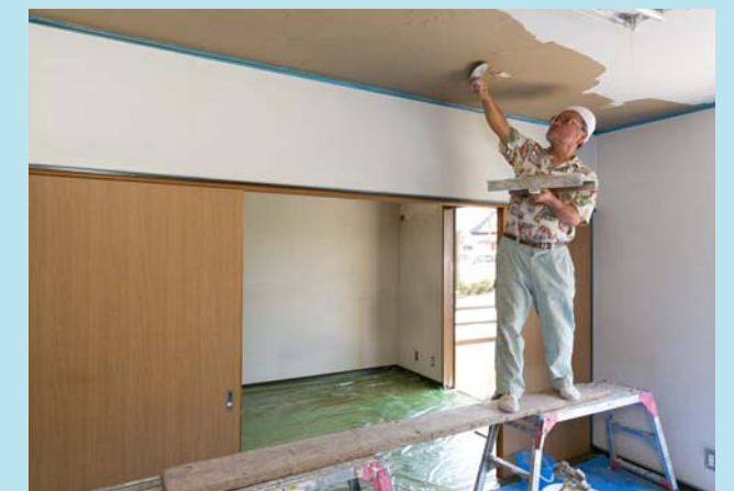
職人が壁にまんべんなく電磁波対策珪藻土「オールアースパウダー」を塗っています。乾くと色は薄いベージュ色になります。
