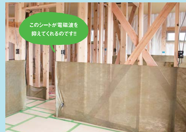
掛川市の新築現場。 電磁波対策シート「スパンボンド」を取り付けた時の様子。
