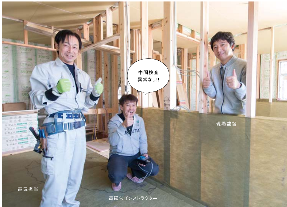
静岡市葵区の現場。「電磁波対策シート」の施工が終わり、電磁波中間検査の様子。
