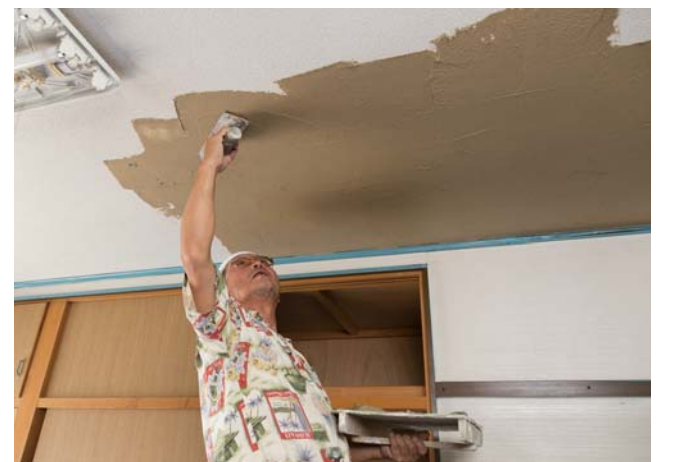
電磁波対策珪藻土を塗る様子。乾くと色は薄いベージュになります。
