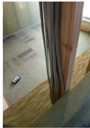
屋内配線から守るよう電磁波対策シートを張っていきます。
