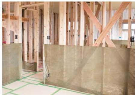
【掛川市の新築現場】「スパンボンド」を取り付けた時の様子。
